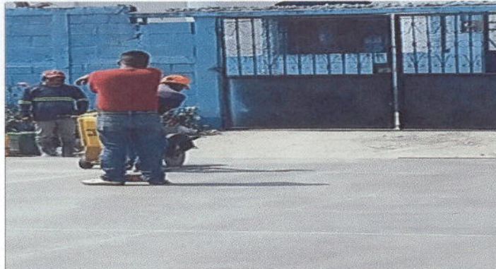
Foto 2: Cortando la fundición de la loza del patio de la escuela
