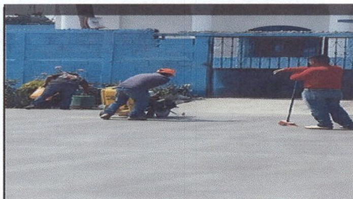
Foto 3: Haciendo los ultimos cortes de loza de patio de la escuela
