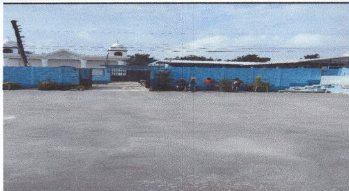
Foto1: Finalizando la fundición de patio de escuela.
